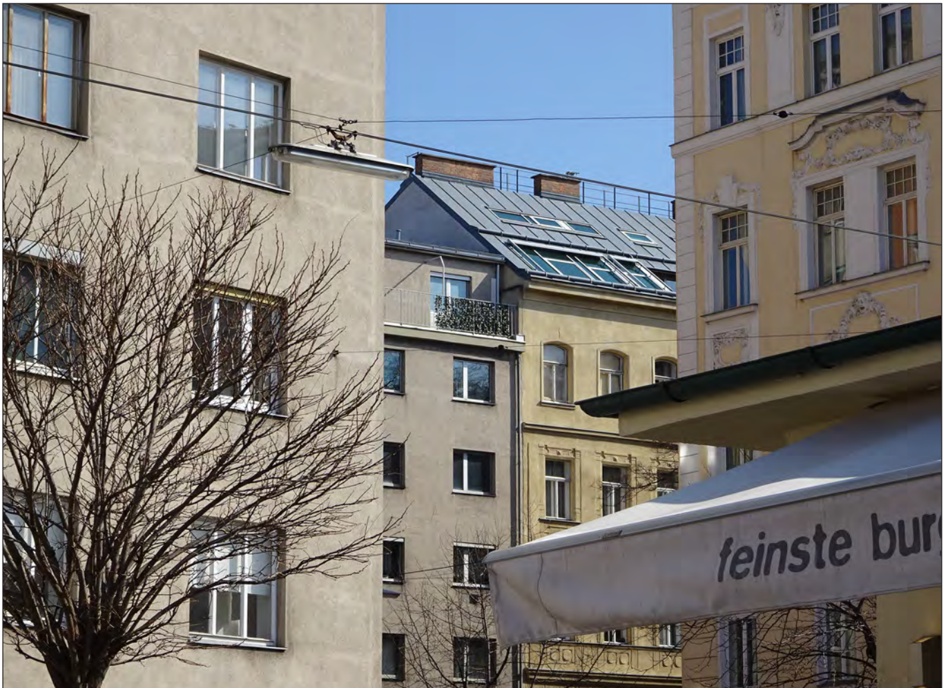
Auch eine Facette der Wiener Baupolitik: Systematischer Ausbau der Dachtagen (Foto: Christiane Schneider)
