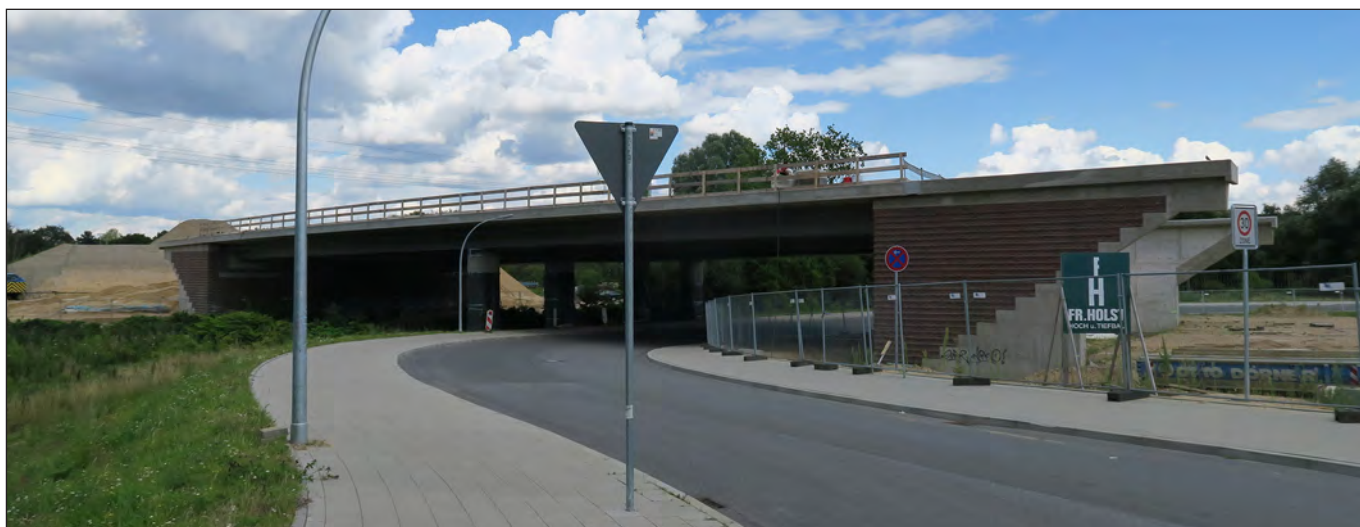
Brückenneubau über den Ernst-August-Kanal und Vogelhütendeich für die Verlegung der Wilhelmsburger Reichsstraße, 7.8.2017 (Foto: NordNordWest, CC by-sa-3.0 de)
