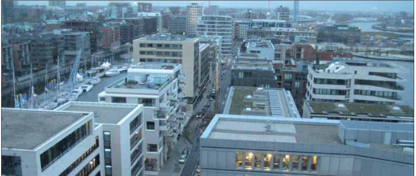
Klotzchenbau in der Hafencity (Foto: M. Joho)
