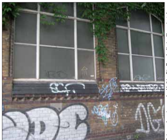
Dringend sanierungsbedürftig: Die Turnhalle im Karoviertel
