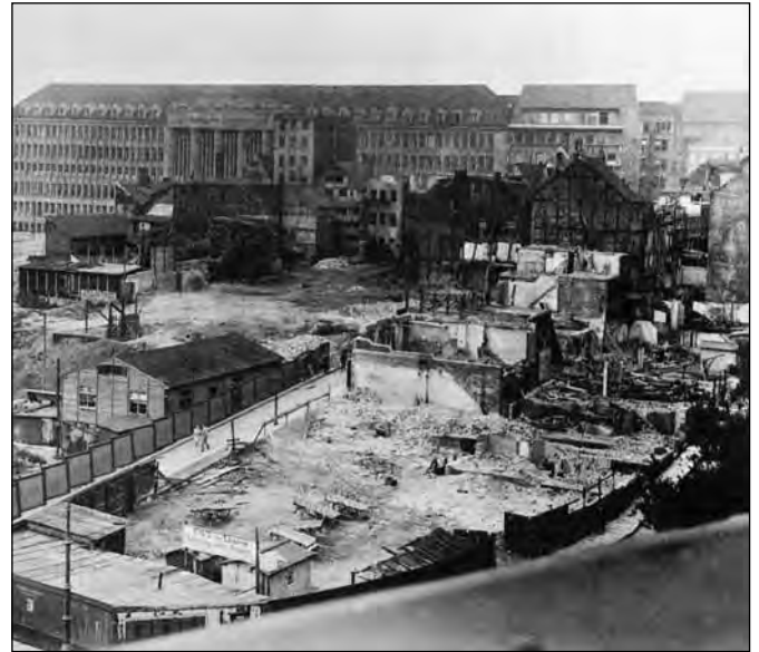
Abbruch von Teilen der Hamburger Altstadt, ab 1928, im Hintergrund das Kontorhaus von Karstadt (aus: Dahms, a.a.O.)
