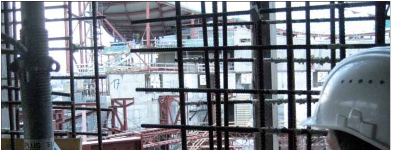
Immer noch unfertig: die Konzertsaal-Baustelle (M. Joho)
