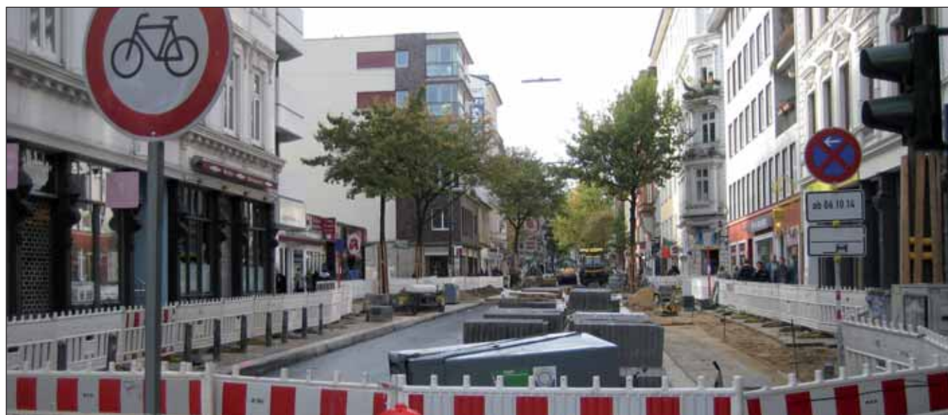
Baumaßnahme Lange Reihe, Ende Oktober 2014 (M. Joho)
