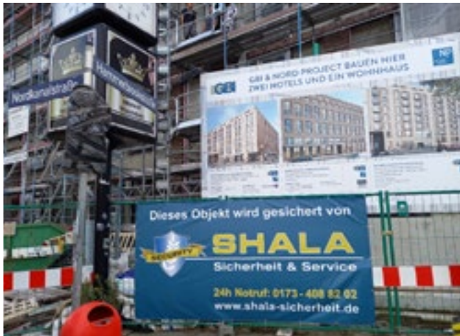
Hammerbrooker Verhältnisse: Zwei Hotels, ein Wohngebäude
