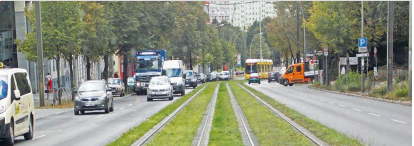
Bild 9 – Berlin, Hauptverkehrsstraße mit Rasengleis
