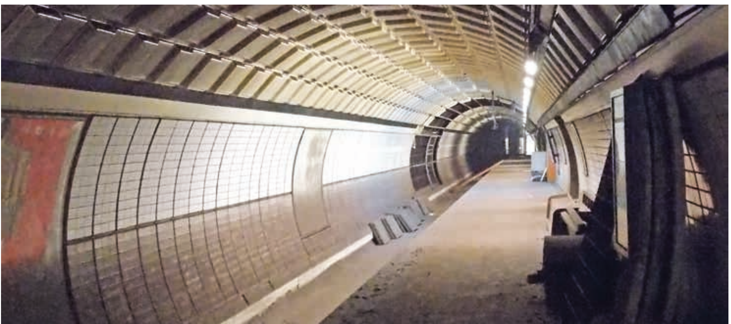
Bild 6 – Künftiger U5-Bahnsteig Hauptbahnhof Nord in Richtung St. Georg, von 1965 bis 1968 auf Vorrat gebaut
